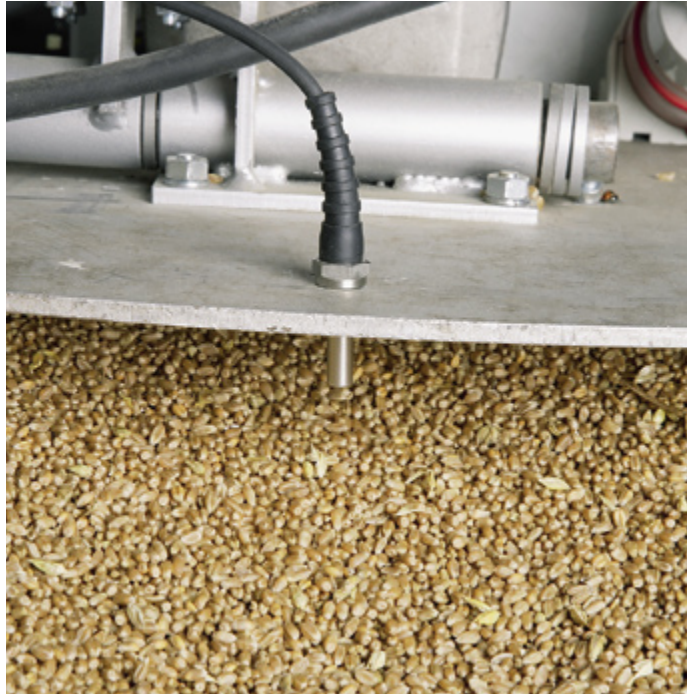
...lassen sich die Temperaturmesswerte übertragen, die der Sensor am Trichterausgang während einer Überfahrt sammelt.
