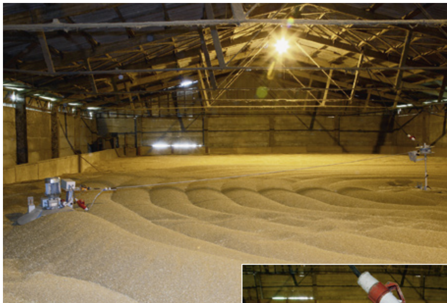
Für Lager über 200 t empfiehlt sich das zeitsparende Kreis-Lauf-System (2 300 Euro Aufpreis). Der Kornknecht zieht hier schneckenförmig seine Runden völlig alleine.
